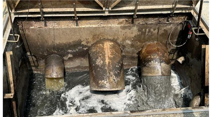
Mit dem Runtime-Modus stehen unterschiedlichste Reinigungsprogramme zur Auswahl. Abgestimmt auf Material, Durchmesser, Höhenunterschied und Länge der Abwasserdruckleitung werden hierbei spezifische Spül-Algorithmen gewählt. Damit gewährleistet die Luft-Wasser-Spülung LW87 die vollständige Entfernung von losen Teilen und Fettablagerungen aus der Leitung.
