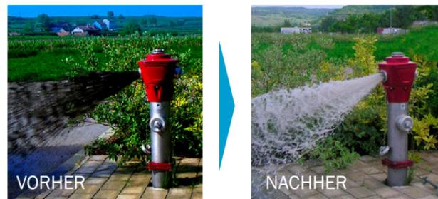
Die Rohrspülung erfolgt über Hydranten und Entleerungen. Bei Endleitungen wird das Luft-Wasser-Gemisch über den Hausanschluss herausgespült.
