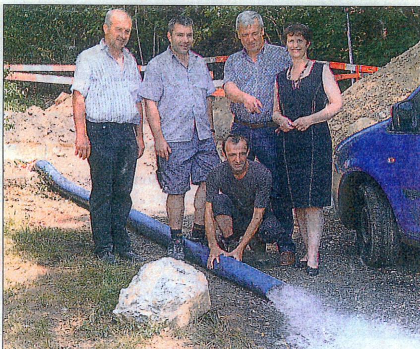
Bürgermeister Wolfgang Gössinger, Wassermeister Christian Weber, Ortsvorsteher Richard Rötzer, Bürgermeisterin Anna Steindl und davor kniend Harald Anton begutachteten am Donnerstagvormittag in der Nähe des Wasserspeichers die Reinigung der Rohre im Wolkersdorfer Gemeindegebiet.
