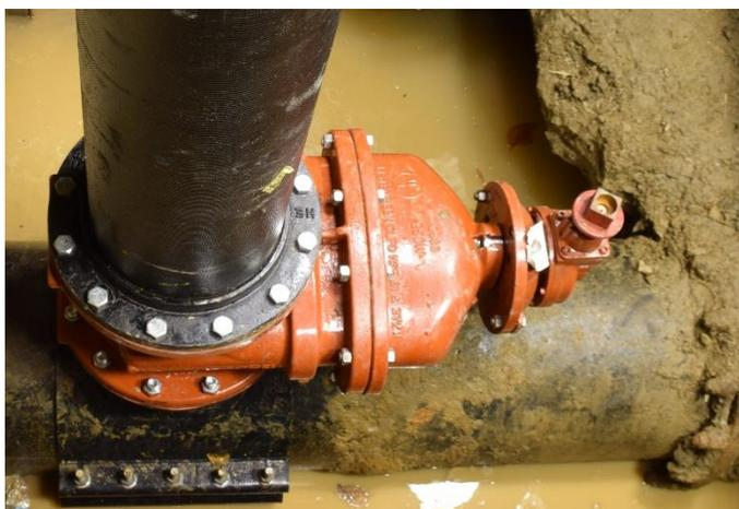
Entnahmeschleuse mit Steigleitung am Endpunkt der Inspektion
