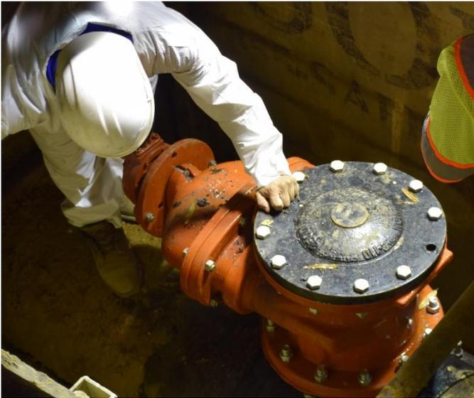
Einbringungsschleuse, installiert von DC Water Mitarbeitern
