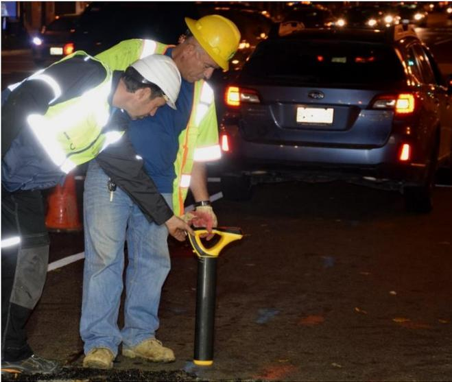
Ortung der Rohrleitung und des MTA Pipe-Inspector
