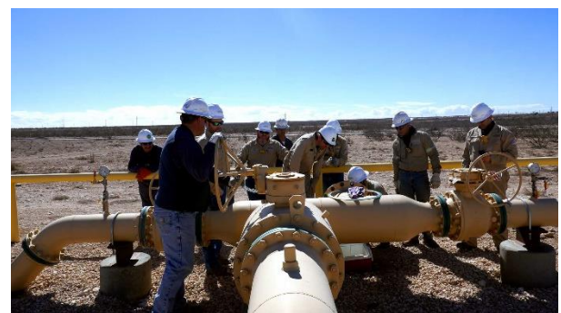
MTA Pipe-Inspector® Inspektion, Startpunkt
