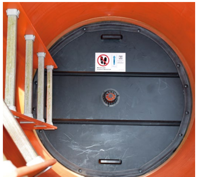
MTA SP 1000 vollständig auf die Berme auflegen und Laschen niederdrücken
