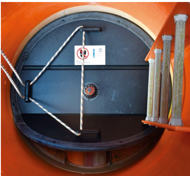
MTA SP 1000 im Schacht ausrichten (Fließrichtung beachten - blauer Pfeil am Aufkleber)
