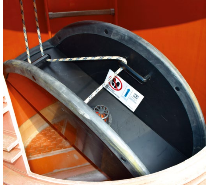
Einbringen mittels Seil in den Schacht
