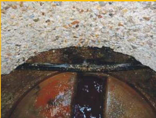
Betonkorrosion
